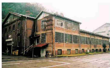
ジャパン マリンユナイテッド 第2電氣工場
