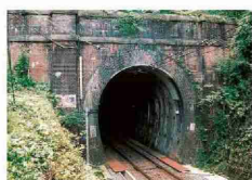
清道トンネル(明治37年)
