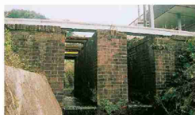
溝渠(真倉、一本杉踏切近く)
