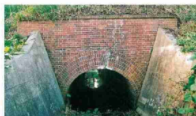
溝渠(円満寺、アーチ)
