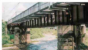
第五伊佐津川橋梁(十倉・京田、伊佐津川) 明治37年
