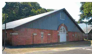
旧北吸浄水場配水池
