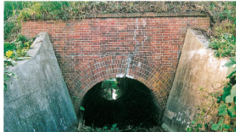
溝渠（円満寺、アーチ）
