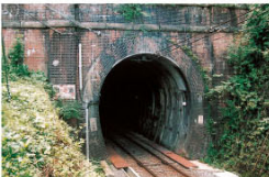
清道トンネル（明治37年）
