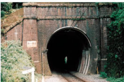
第一真倉トンネル（明治37年）
