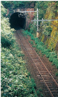
白鳥トンネル（明治37年）
