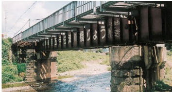
第五伊佐津川橋梁（十倉・京田、伊佐津川）明治37年
